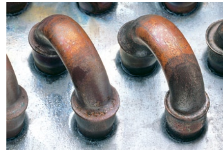
Пластиначатый теплообменник – колена возвратной циркуляции
